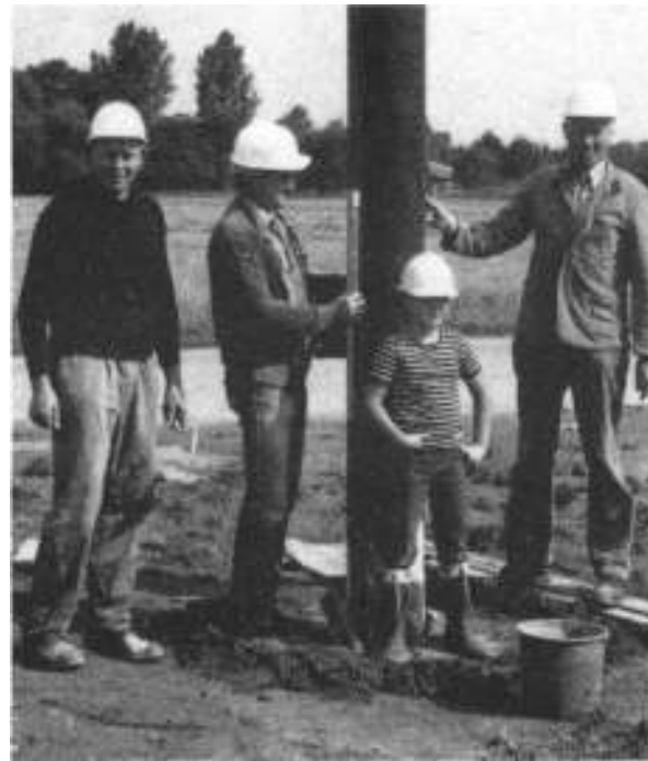
Geschafft! „Bauleiter“ Schulte prüft mit sachkundigem Blick. Die Schweißer Alfred Füssel und sein Kollege sind zufrieden.
